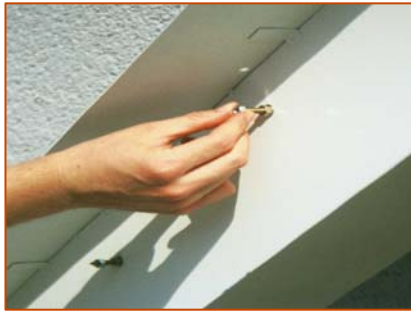
Einschrauben der Distanzstücke
